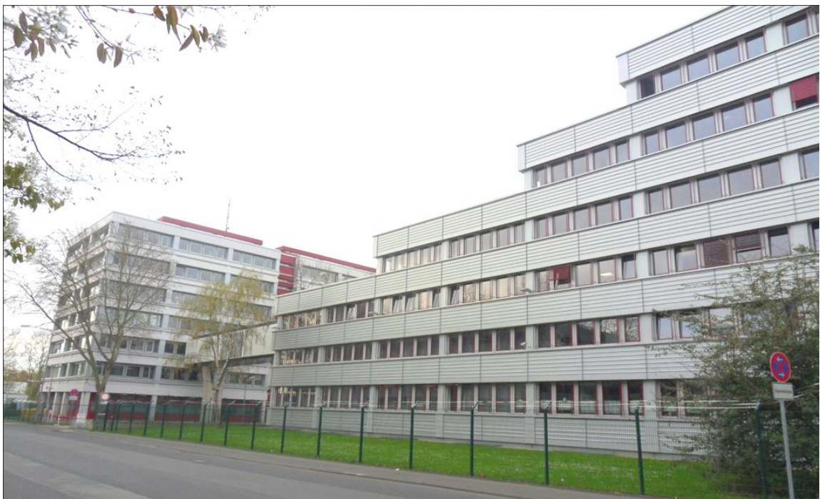
Ryc. 3 Budynek HLKA w Wiesbaden
